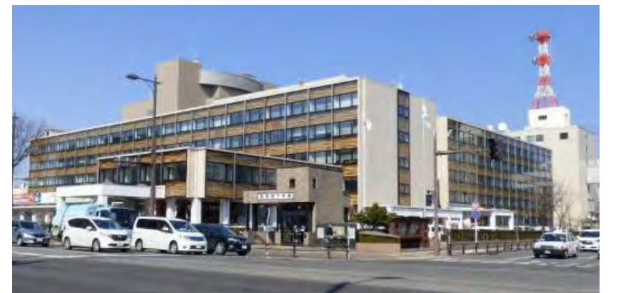
改修後(6階建て)
