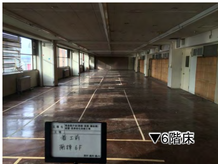
南棟6階 着工前 (写真提供元:青森県庁)
