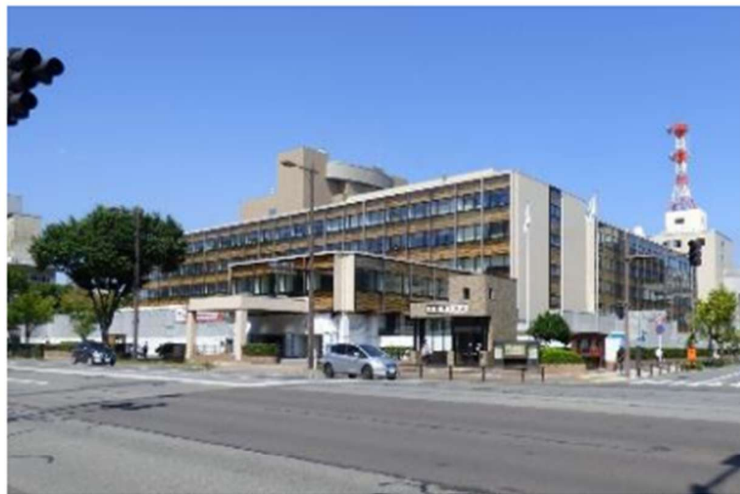
施工状況（平成30年8月28日撮影）
