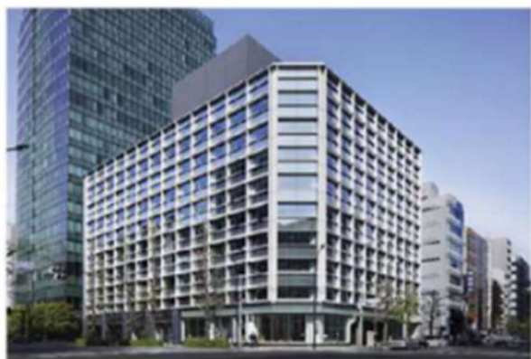
Phase3:2024年1階外装・内装・設備改修
