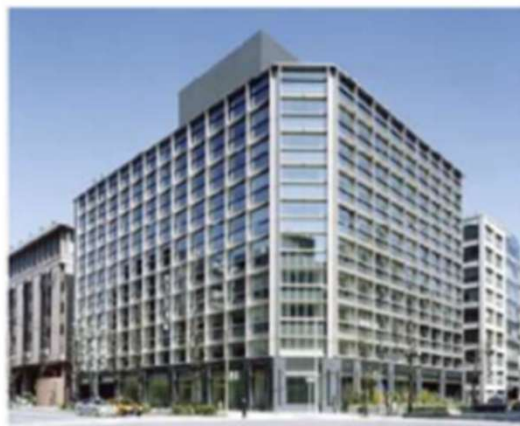
Phase2:2002年外装・設備・耐震改修 1階は格式高い石貼り、上階は竣工時グリッドを意識したルーバーとライトシェルフが設置され日射制御性能向上
