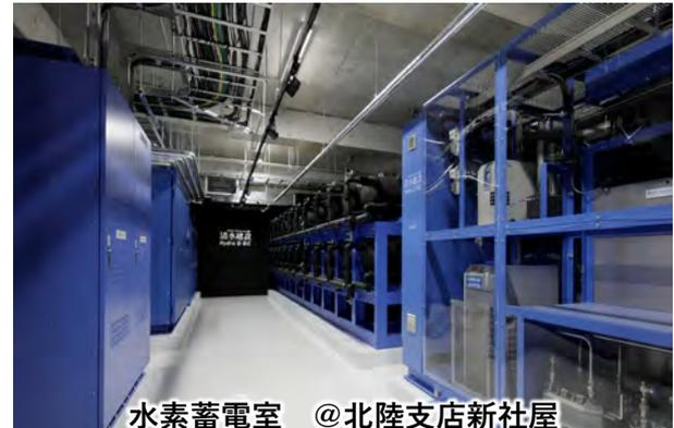
「CO2フリー水素利用システムHydro Q-BiC®」は、太陽光発電設備の余剰電力によりグリーン水素を製造し蓄エネを行うことで再生可能エネルギーの地産地消を可能とする。また、本社屋ではBCP電源としても活用しており、近年の気候激化に備えるエネルギー自立型建築物としての役割を担っている。経済産業省が求める「再生エネルギー由来の水素の製造と活用技術」の実例であり水素社会を先導するものである。
