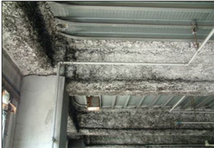
耐火被覆用吹付けアスベスト 例
