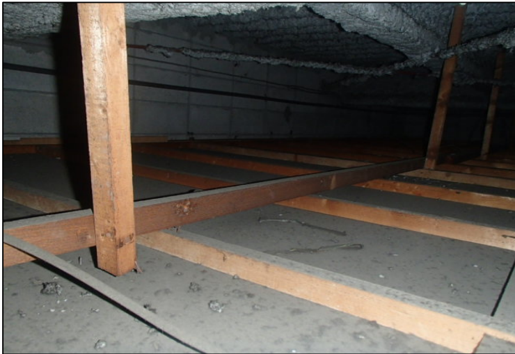
天井裏面のアスベスト落下・堆積状況 ①
