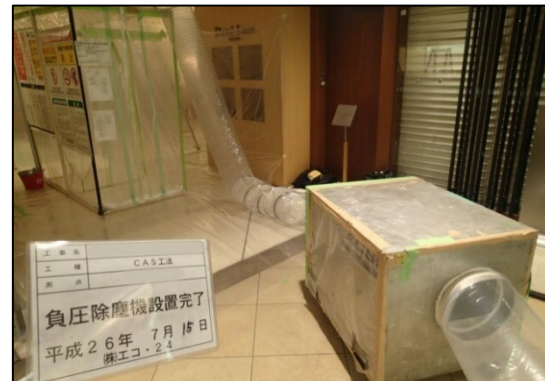
アスベスト対策工事時の負圧装置設置状況
