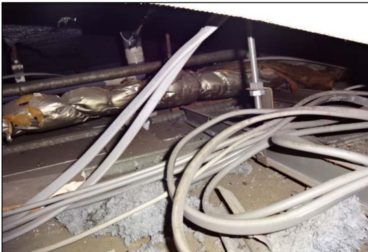
天井裏面のアスベスト落下・堆積状況 ②
