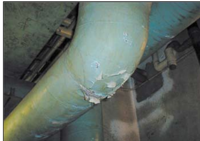
配管エルボー石綿保温材（破損）例
