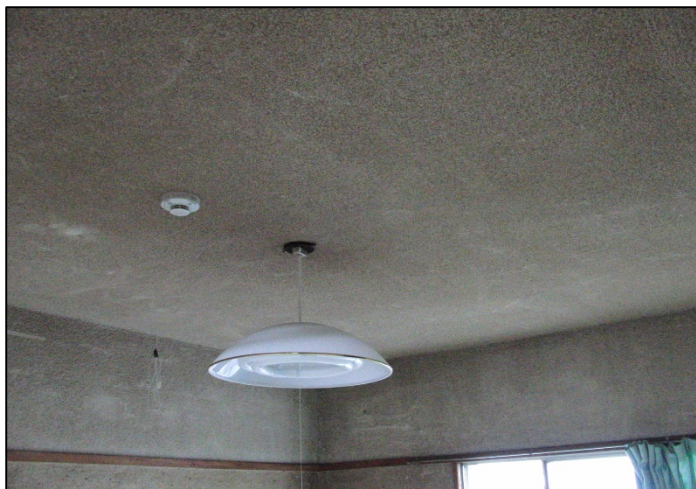
吹付け仕上げ塗材（内装） 例
