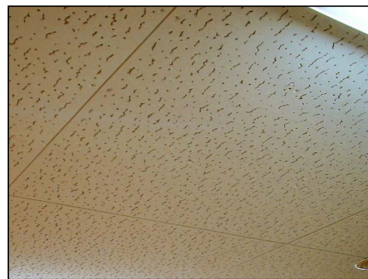
天井材（吸音ボード） 等
