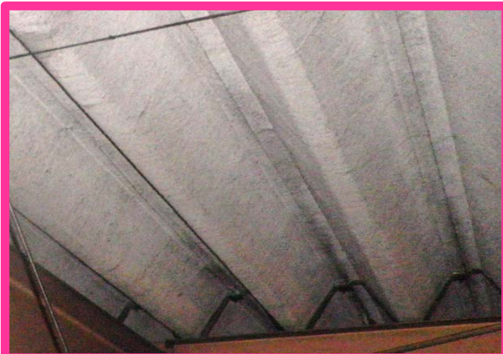
折版屋根裏打ち断熱材 例
