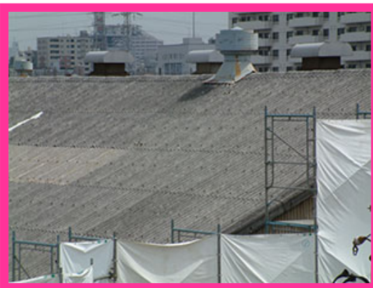
屋根材（波板スレート） 等
