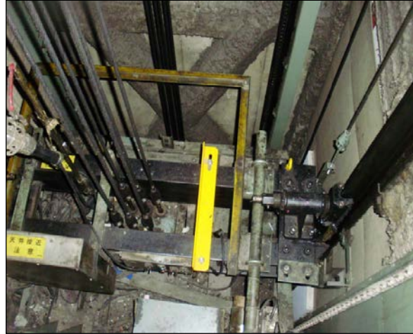
※エレベーターシャフト
