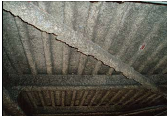
断熱用吹付けアスベスト 例
