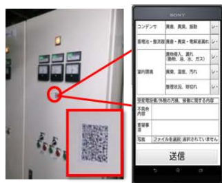
点検対象に貼り付けたQRコードを読み取ると、点検項目が表示される。
