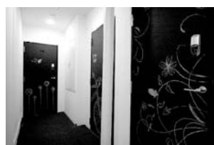
(改修後) 黒板塗装を施した各個室のドア
