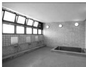
（改修前） 共同浴場
