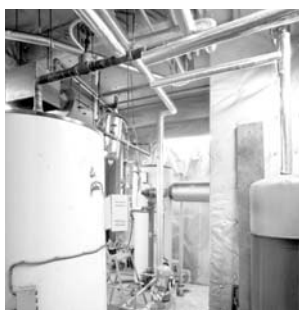
(改修前) ボイラー室
