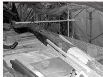
写真4 大梁の補修状況
